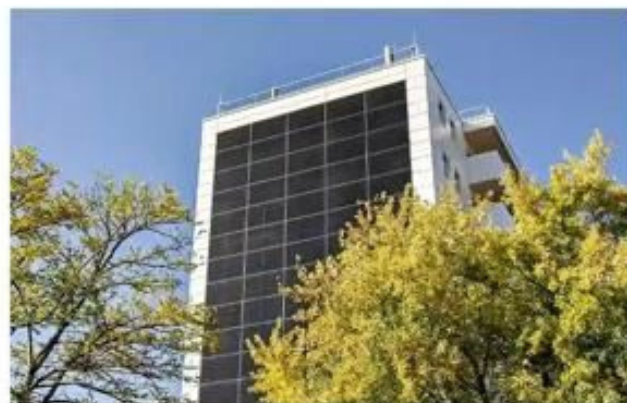
Imposante Wand: So sieht die Fassade aus Photovoltaik-Elementen in der Ehlersstraße aus. FOTO: GRAMM
